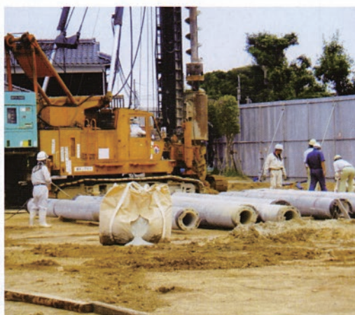
着々と進行する交流センター新築工事
