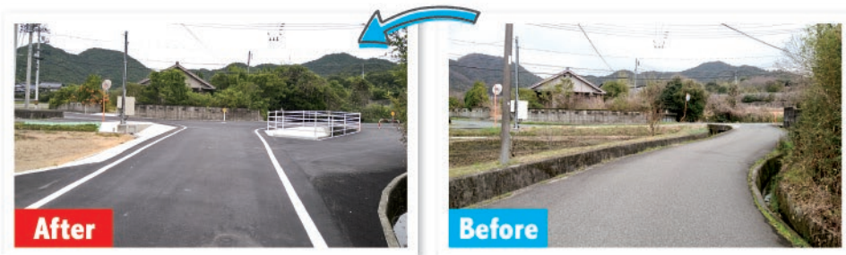
岡交差点改良工事 完成
