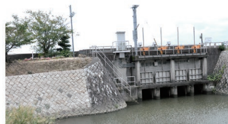
南蛮樋/陸側に南蛮樋門(遮蔽板を上下に動かす)、海側には唐樋門(遮蔽板を海水圧で動かす)となっていて機能が比較でき、昔は石門の板戸でした。
